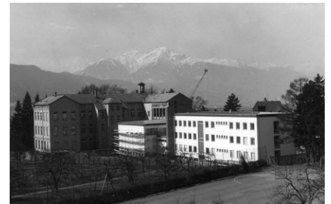
Erweiterung des Gymnasiums
