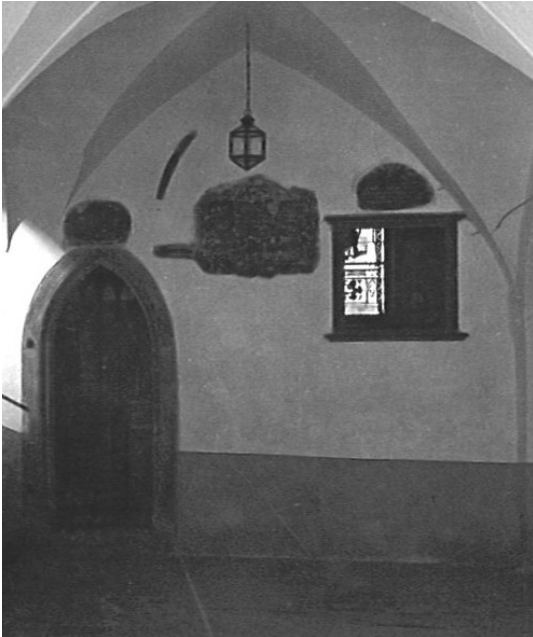
Südliche Außenwand der Erhardkapelle (ca. 1930): die dunklen Flächen entsprechen den Inschriften
